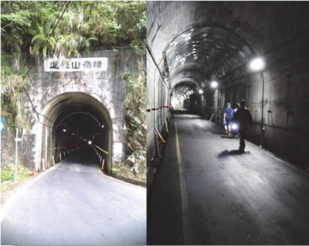
圖 7 橫嶺山隧道照片
